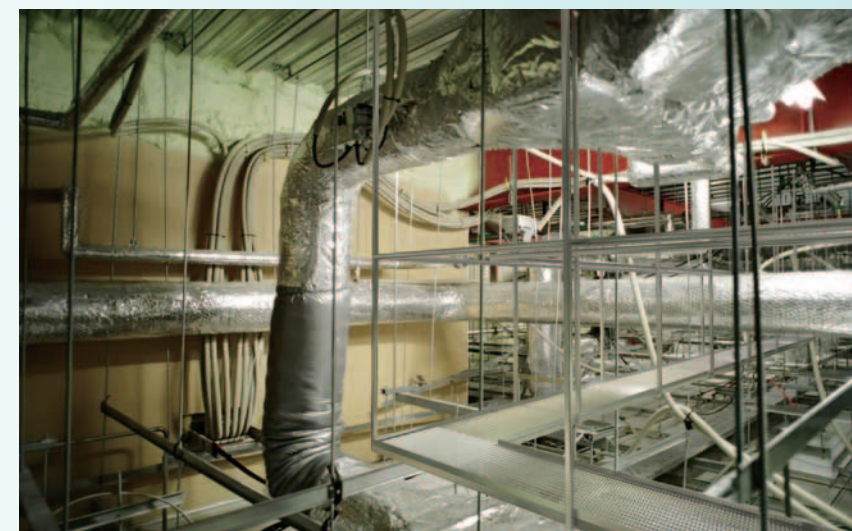
在来工法(LGS工法) [軽量天井下地、石膏ボード、化粧ケイカル]
