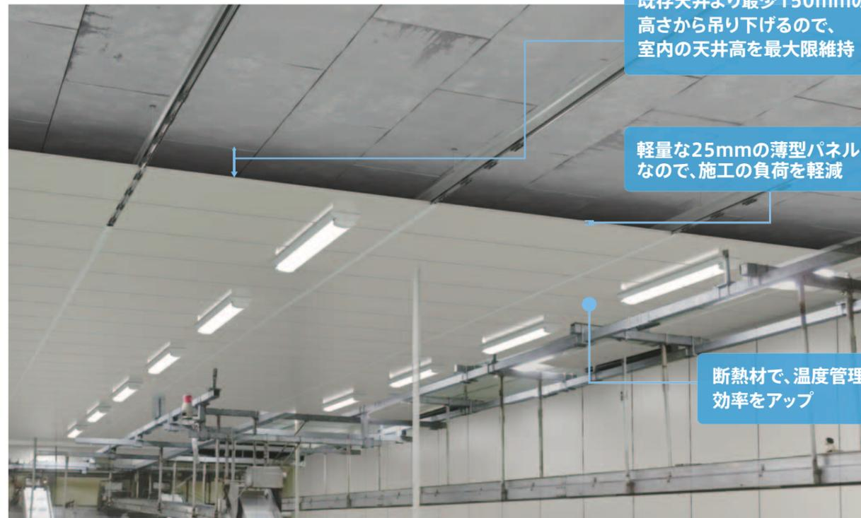
既存天井より最少150mmの高さから吊り下げるので、室内の天井高を最大限維持
