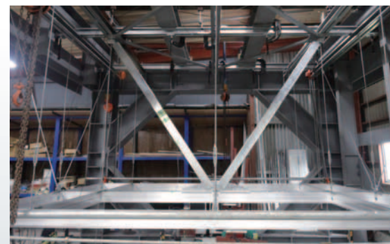
〈水平震度法に基づく水平加力試験を実施〉
