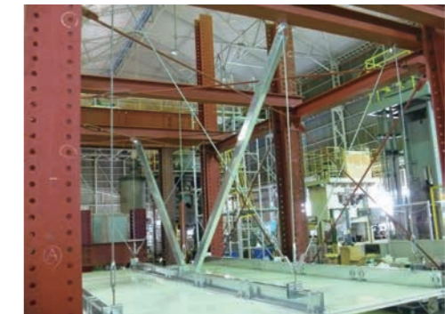
<水平震度法に基づく水平加力試験を実施>
