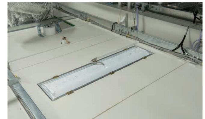
照明の交換、メンテナンスを天井裏から行えるため、室内側の気密性が確保できます。
